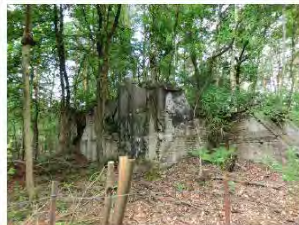
Gesprengter Munitionsbunker [1081] (Juni 2016)
