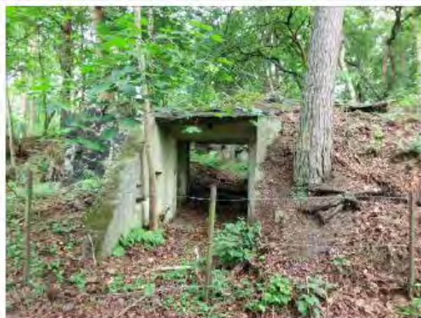
Gesprengter Munitionsbunker [1116] (Juni 2016)
